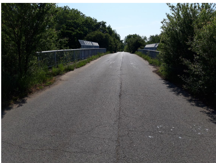
Pohled ve směru staničení
