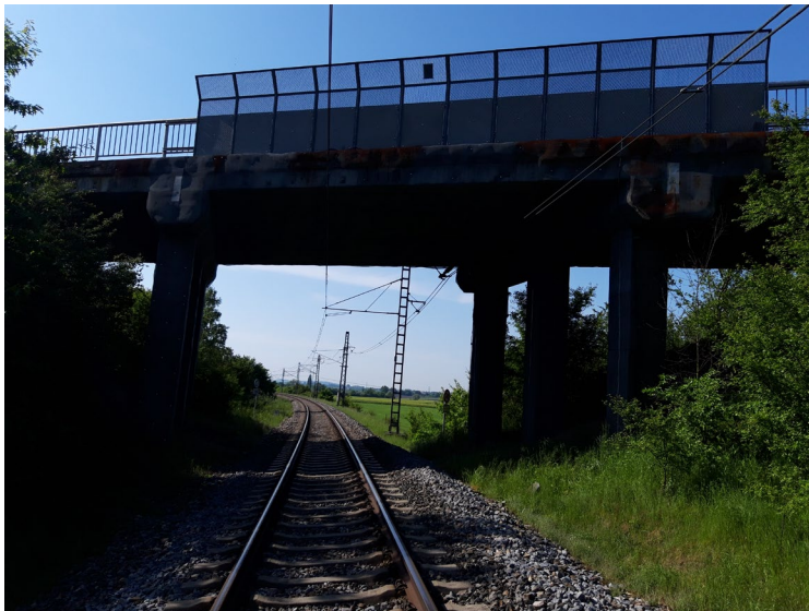
Pohled na levou stranu mostu
