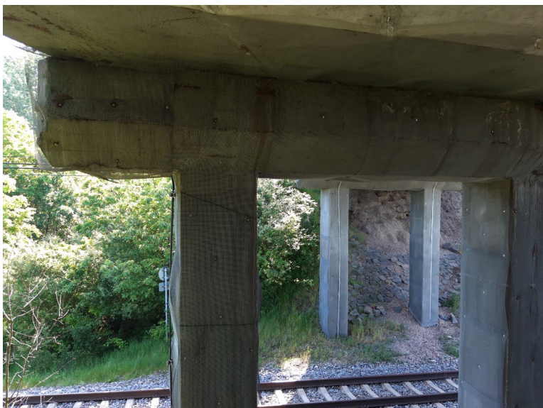
Podhled nosné konstrukce v poli 1 – ukončení ocelové sítě
