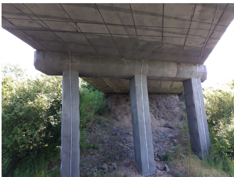
Podhled nosné konstrukce v poli 2
