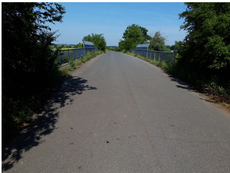
Pohled proti směru staničení
