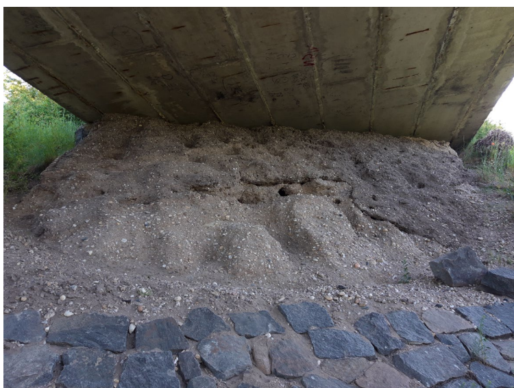
Podhled nosné konstrukce v poli 3
